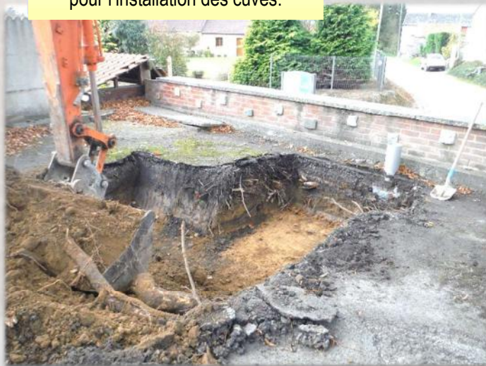
À la mairie, les travaux ont commencé avec le terrassement pour l'installation des cuves.
