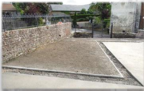
Pose de croûte de pierre pour la retenue des terres.
